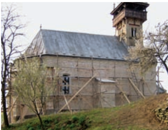
3. A templom északi homlokzata kutatás közben
